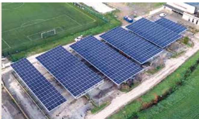
Ombrières photovoltaïques de parking de l'espace culturel de Sainte-Anastase
