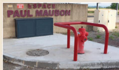
*Fabrication et pose du coffret de protection des armoires électriques et protection de la borne incendie de l'espace Paul MAUBON*
