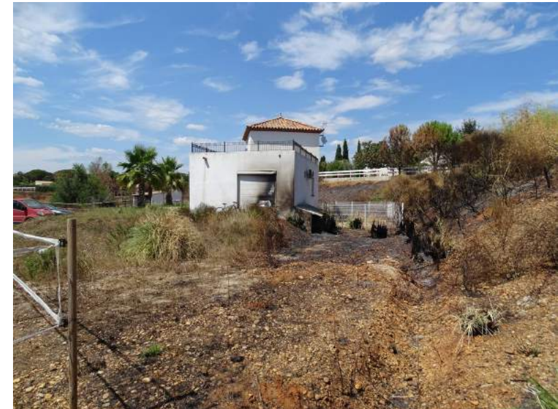
Végétation trop abondante, trop proche
