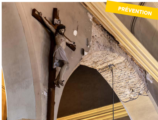
Église Saint-Martin d'Arnèke © Fondation du patrimoine - MyPhotoAgency - Alexandre Lard
