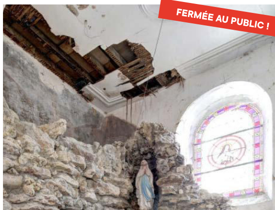
Église Saint-Leu de Sévigny-Waleppe © Fondation du patrimoine - MyPhotoAgency - Xavier Chkondali
