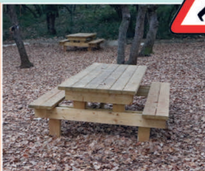
Assemblage et fixation sur plots béton de deux tables extérieures à l'école du Petit Bois très appréciés par les enfants lors des récréations
