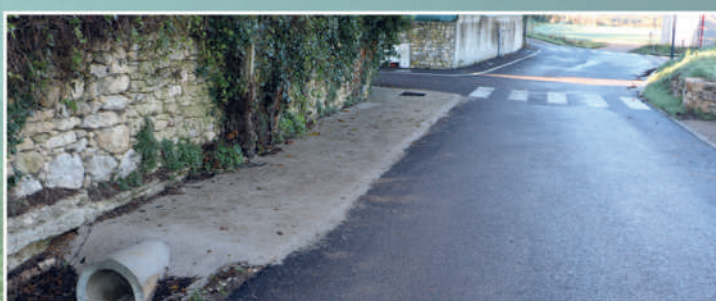
Sécurisation du fossé en sortie du parking de VIC
