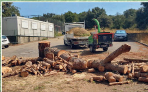
Abattage du pin aux racines superficielles aux abords de la cantine
