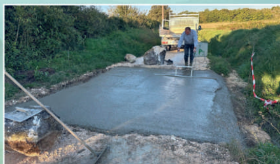
Réalisation de passages d'eau en béton afin d'éviter l'érosion de chemins communaux
