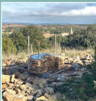
La fondation et les premières rangées de pierres
