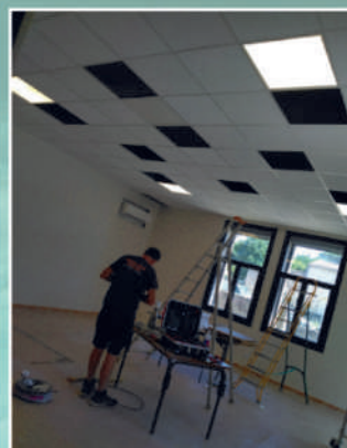
Mise en place du plafond acoustique et rénovation électrique complète de la salle des mariages
