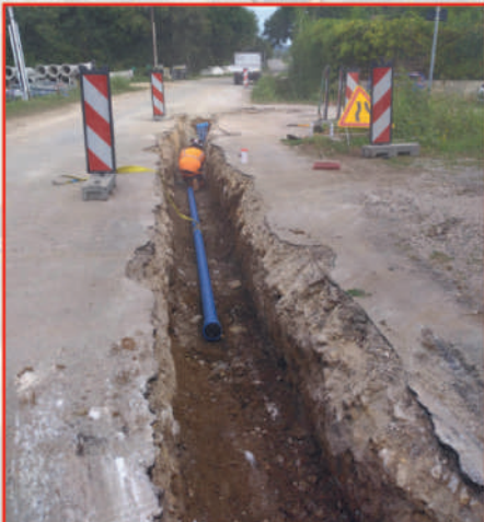
La pose du nouveau réseau d'Eau Potable sur la RD 418
