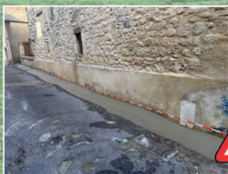
Travaux d'étanchéité des voiries Rue de la Paix à Aubarne
