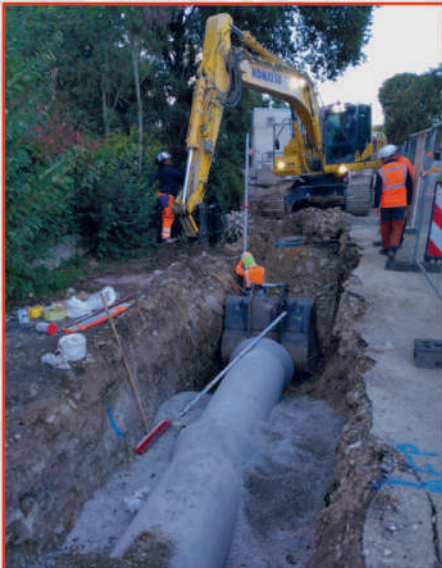
La pose des buses béton du nouveau réseau pluvial sous la RD 418
