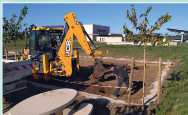
Terrassement et réalisation des massifs béton pour l'installation des jeux d'enfants
