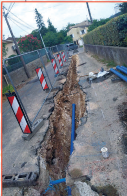
La pose du nouveau tuyau d'Eau Potable Rue de la république à Russan
