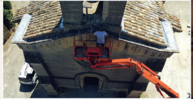
Réalisation des finitions, en bordure des toits et du clocher, au moyen d'une nacelle.
