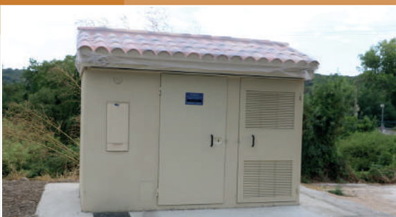
Renforcement de réseau électrique et pose d'un nouveau transformateur installé hors zone inondable
