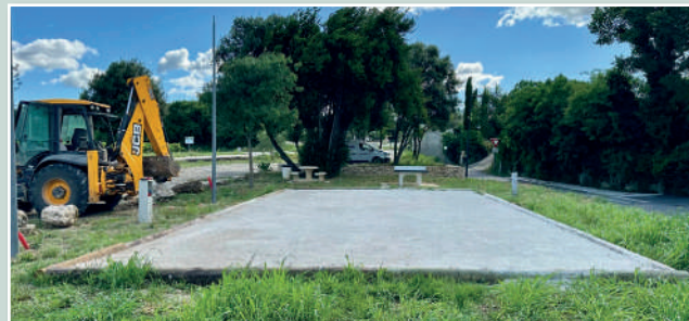
Poursuite des travaux du jeu de boule à Vic (Bois, géotextile, clavicette et implantation de éclairages)
