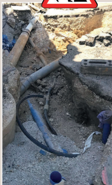
Rénovation des réseaux d'Eau potable et des Eaux usées Rue de la Paix Angle Rue de la Pente
