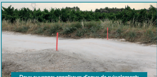
Deux ouvrages canaliseurs d'eaux de ruissellements
