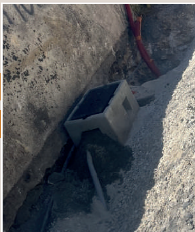
Reprises et rénovation des fourreaux et coffrets de réseaux secs
