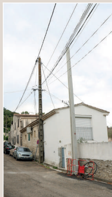
Préparation de l'enfouissement des réseaux d'une partie de l'Avenue du Pont. Pose d'un poteau provisoire dans l'attente de la poursuite des travaux
