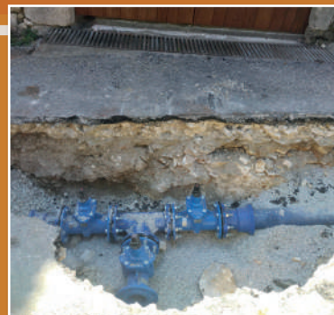
Pose de vannes de sectorisation réseau d'Eau potable Rue de la Paix
