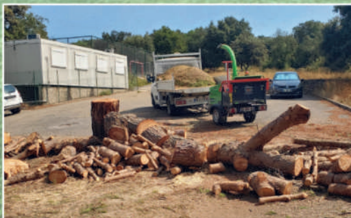
Abattage du pin aux racines superficielles aux abords de la cantine
