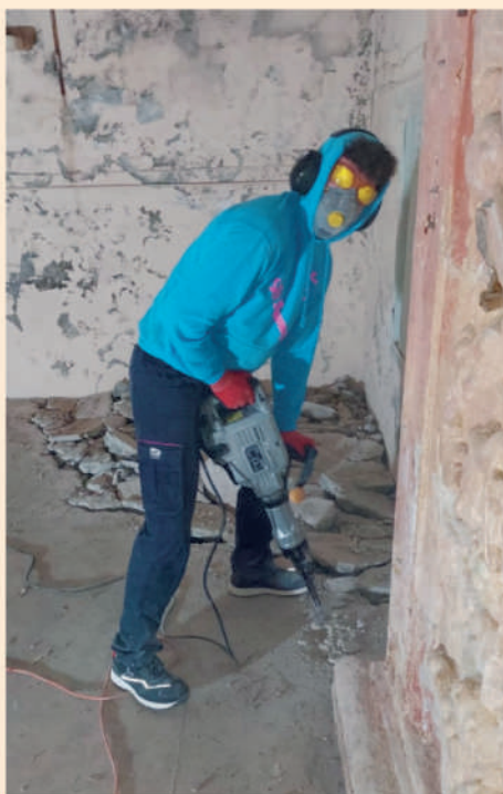
Premiers morceaux de dalle cassés avec un marteau électrique par un bénévole de l'association
