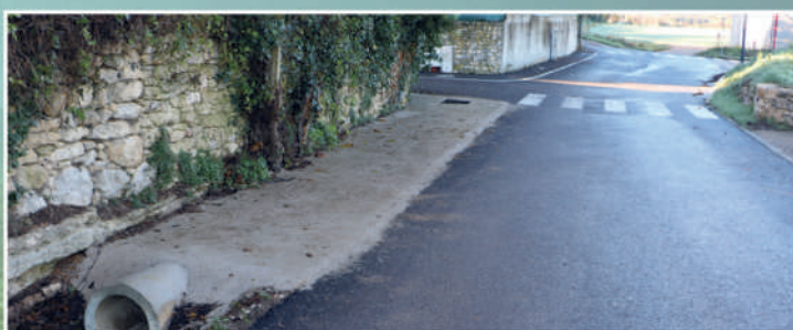
Sécurisation du fossé en sortie du parking de VIC
