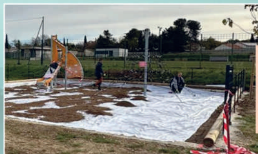
Mise en place de la finition en graviers ronds amortissants
