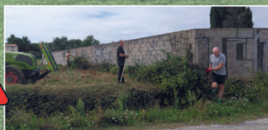
Préparations de abords des cimetières d'Aubarne et de Vic avant enduits
