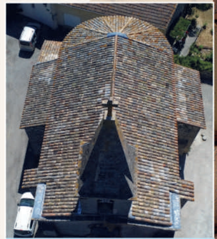
La toiture après rénovation
