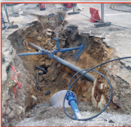
Le maillage du réseau d'Eau Potable en cours de branchement, croise le tout à l'égout et les buses béton du nouveau réseau pluvial
