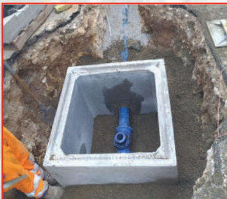
La pose de vannes de sectorisation du réseau d'Eau Potable
