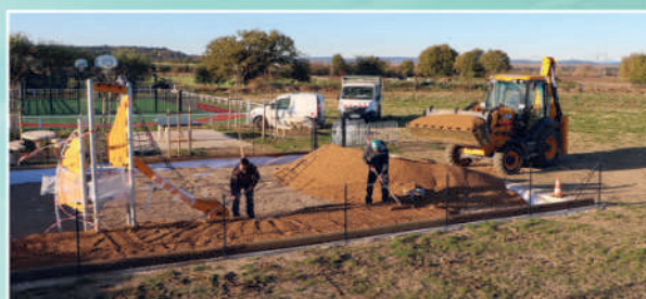
Mise en place de la finition en graviers ronds amortissants
